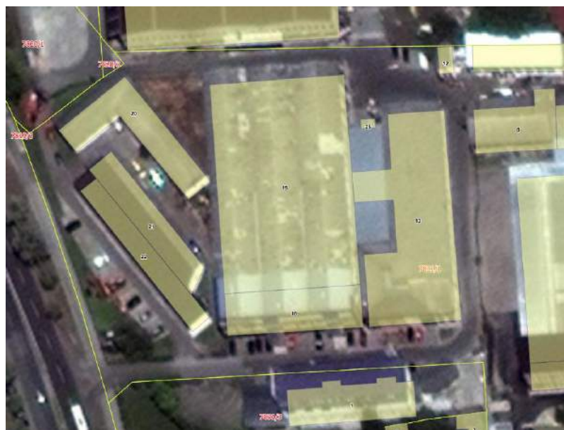
Građevinski objekti br. 18 i 19 na parceli br. 7831/1 K.O. Novi Sad I
